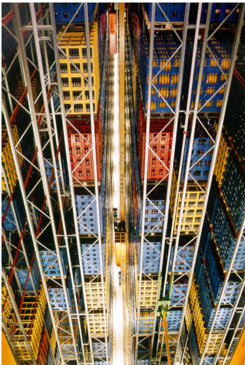
Armazenagem Vertical Automatizada com Transelevadores
